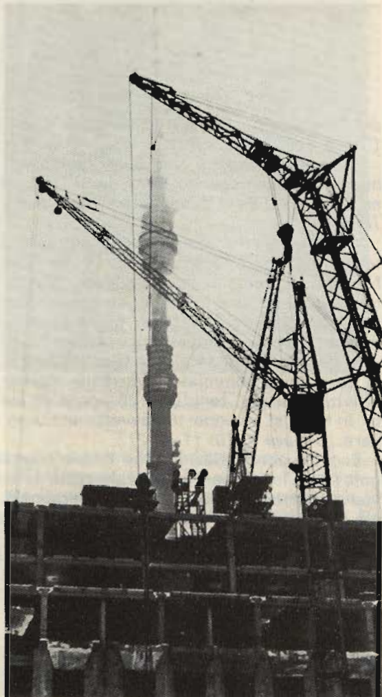
Fig. 5 - Il nuovo Centro Radio-TV in costruzione a Ostankino per le Olimpiadi di Mosca. Questo consiste di tre complessi: per la Radio, Televisione e Film. Il centro di sei piani, ospiterà 1200 persone fra giornalisti radio-TV e tecnici. Sullo sfondo la torre delle antenne radio-TV di Mosca.
