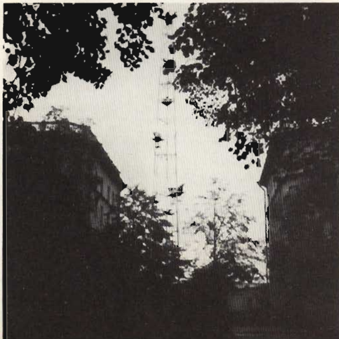
Fig. 7A - La torre per le antenne a microonde del Centro Televisivo di Leningrado sul viale Petrogradskaja. Queste provvederanno al collegamento via etere con Mosca per le riprese olimpiche.
